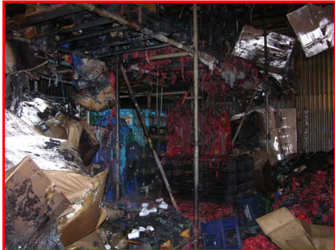
Bild 10: Schadensbild der untersten Reihen
