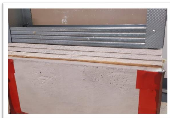
Abbildung 12: Fertigung gleitender Deckenanschluss: unten Betonkörper, darüber Verbindungsschichten, oben: Gipskartonwand einseitig beplankt
